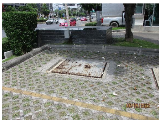
บ่อดักน้ำก่อนระบายน้ำลงสู่ท่อระบายน้ำที่สาธารณะ
