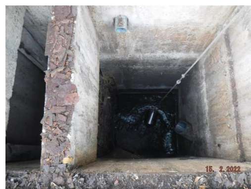
บ่อดักน้ำก่อนระบายน้ำลงสู่ท่อระบายน้ำที่สาธารณะ
