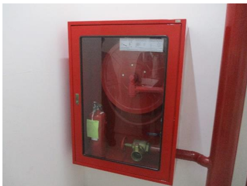
รูปที่ 3-5 การตรวจสอบสอบอุปกรณ์สำหรับแจ้งเตือนภัย และอุปกรณ์สำหรับป้องกันอัคคีภัย
